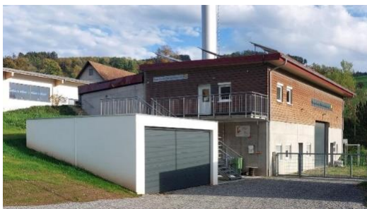
Figure 1: Le bâtiment de la chaufferie avec la trémie pour les copeaux de bois.
