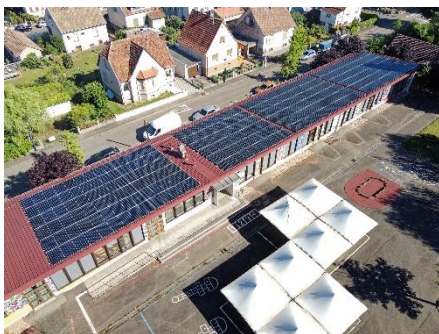
Figure 1: Les installations photovoltaïques sur les toits de l'École Maternelle des Gravières à Saverne.
