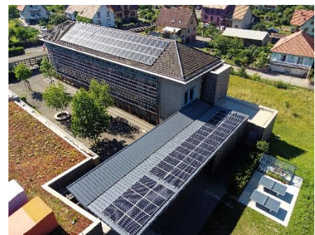
Figure 2: Les installations photovoltaïques sur les toits de l'École à Dossenheim-sur-Zinsel.
