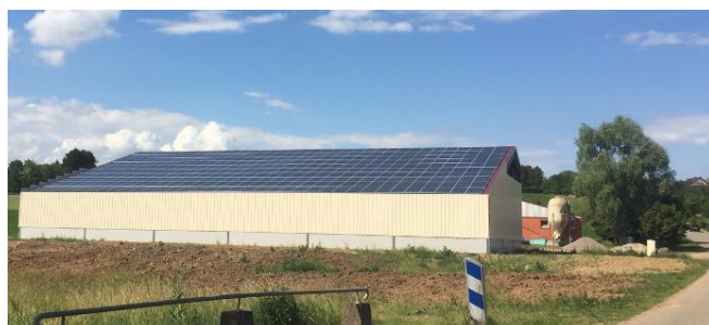
Figure 1: La centrale photovoltaïque à Neugartheim-Ittlenheim.
