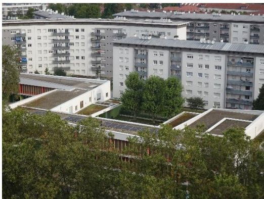
Figure 1: Installation photovoltaïque sur le toit de l'école „Louvois“ à Strasbourg.
