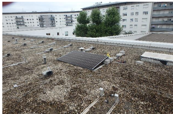
Figure 2: Travaux sur le toit de l'école „Louvois“ à Strasbourg.
