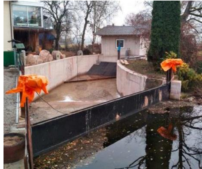
Einlauf & Krafthaus (Blick vom Oberwasser)
