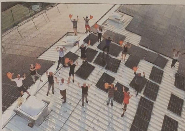
Blick aus der Vogelperspektive auf die Solaranlage auf einem Hallendach der Heidelberger Brauerei. Es handelt sich dabei um die bislang größte Solaranlage der HEG in Heidelberg. Die Brauerei mietet die Anlage und nutzt den Ökostrom zum Großteil selbst. Foto: Holzern
