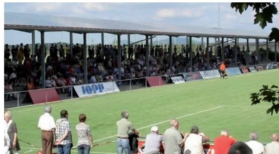
Das Stadionsdach des TSV Großbardorf wird über eine darauf installierte Photovoltaikanlage der FWR finanziert.
